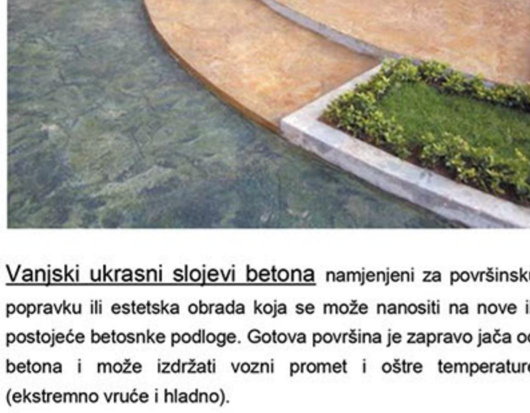
Vanjski ukrasni slojevi betona namjenjeni za površinsku popravku ili estetska obrada koja se može nanositi na nove ili postojeće betonske podloge. Gotova površina je zapravo jača od betona i može izdržati teški vozni promet i oštре temperature (ekstremno vruće i hladno).
